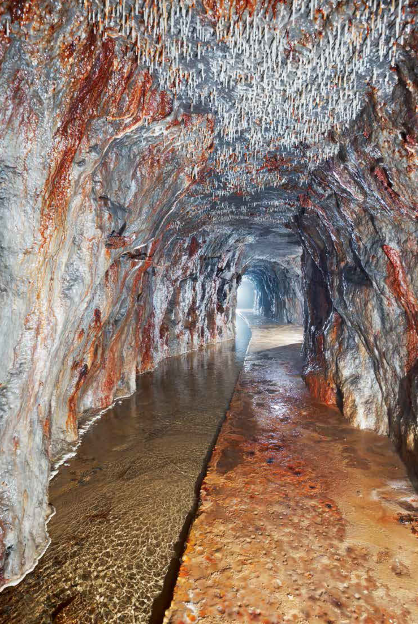
Das glasklare Wasser des Neutorbrunnens fließt den Stollen entlang und mündet am Ende dieser Strecke in die Eichtorquellen.
